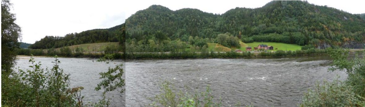
Figur 12: Bilde av Rostad og planlagt påhuggsområde og utgraving til fjell. Bebyggelsen til høyre i bildet må erverves. Kilde: Norconsult.
